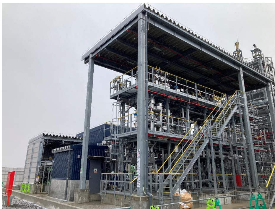
画像：商用初号機として INPEX 社に設置された小型アンモニア合成設備
